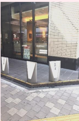
東側角地の段差
