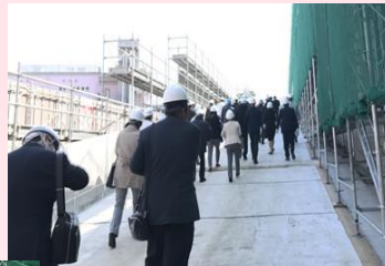
給食の車が行き来することになる1階と3階をつなぐスロープ
