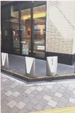
東側角地の段差
